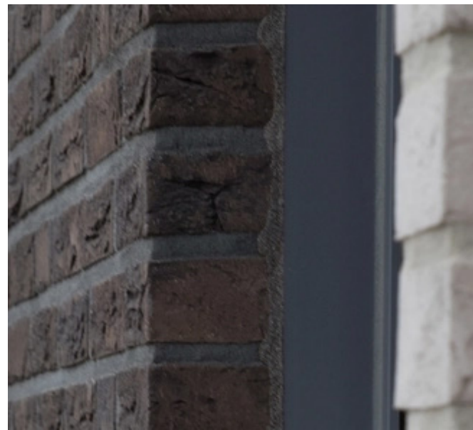
verschillende soorten voegwerk
